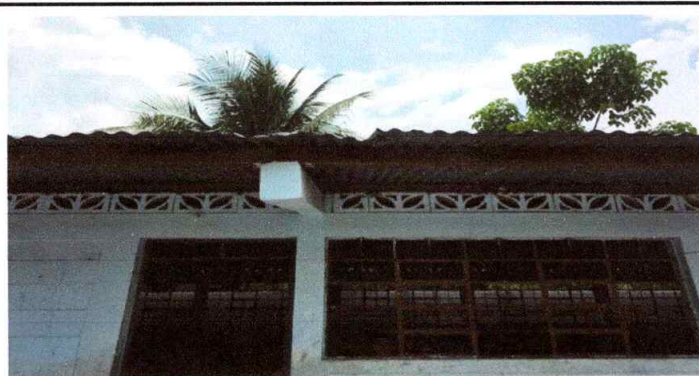
MANTEMIENTO DE ESTRUCTURA DE SOPORTE DE METAL ANTICORROSIVO
