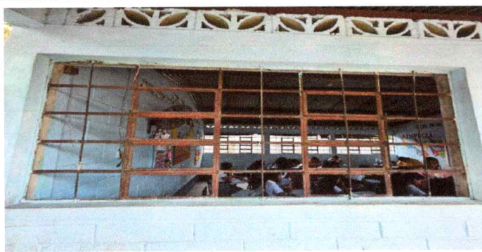
MANTEMIENTO DE ESTRUCTURA DE SOPORTE DE METAL ANTICORROSIVO
