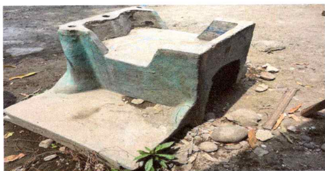
SUSTITUCION DE PILA PLASTICA DE DOS LAVADEROS
