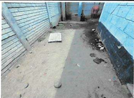
SUSTITUCIÓN DE PISO DE TORTA DE CONCRETO
