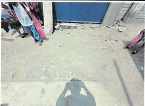
SUSTITUCIÓN DE PISO DE TORTA DE CONCRETO
