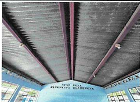
SUMINISTRO Y APLICACIÓN DE PINTURA INTERIOR MARCA CORONA
