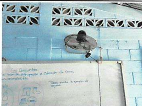
SUSTITUCIÓN DE VENTILADOR DE PARED 16" MARCA NAVIA
