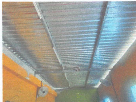
FOTOGRAFIA 6. SUMINISTRO Y SUSTITUCION DE CUBIERTA DE LAMINA ACANALADA POR LAMINA TROQUELADA CALIBRE 26 ALUZINC
