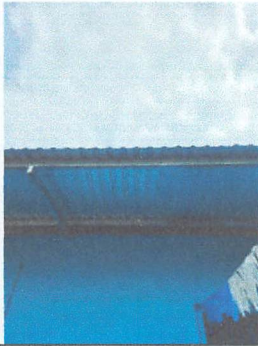
FOTOGRAFIA 7. SUMINISTRO Y SUSTITUCION DE ESTRUCTURA DE SOPORTE DE MADERA POR METAL GALVANIZADO
