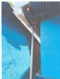
FOTOGRAFIA 5. SUMINISTRO Y SUSTITUCIÓN DE BAJADA DE AGUA PLUVIAL DE METAL POR TUBO PVC 4"
