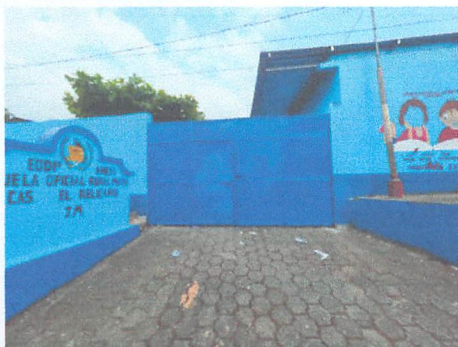
FOTOGRAFIA 1. SUMINISTRO Y SUSTITUCION DE PORTON METALICO 4.26X 2.50 METROS, PUERTA CENTRAL, CON CHAPA YALE, PINTURA ANTICORROSIVA COLOR AZUL
