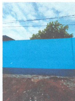
FOTOGRAFIA 2. SUMINISTRO Y SUSTITUCIÓN DE MURO PERIMETRAL EXISTENTE DE BLOCK Y COLUMNAS 20X15CM SEPARADAS A CADA 2.40M CON CIMIENTO DE 50X20CM
