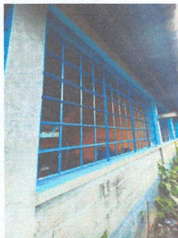
FOTOGRAFIA 3. SUMINISTRO Y REPARACION DE BALCONES, CAMBIO DE PARTES DE PERFILES DAÑADOS, LIJADO, CEPILLADO Y APLICACIÓN DE PINTURA ANTICORROSIVA
