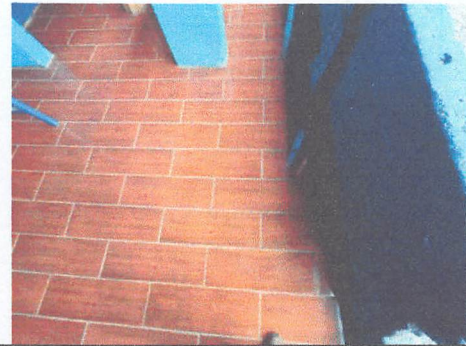
FOTOGRAFIA 8. SUMINISTRO Y SUSTITUCION DE PISO CERAMICO
