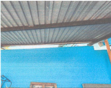
FOTOGRAFIA 9. IMPERMEABILIZACIÓN DE PARED CON IMPERMEABILIZANTE ESTIRENO ACRILICO MODIFICADO CON SILICON
