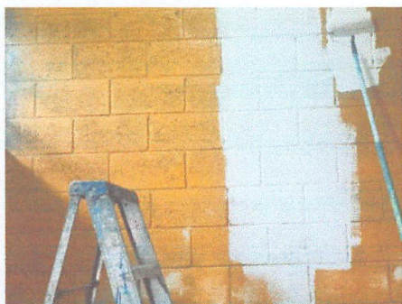
FOTOGRAFIA 9. IMPERMEABILIZACIÓN DE PARED CON IMPERMEABILIZANTE ESTIRENO ACRILICO MODIFICADO CON SILICON
