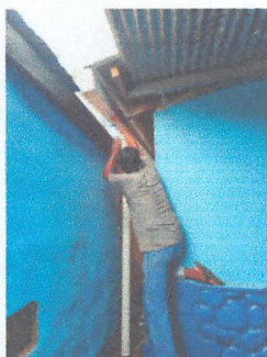
FOTOGRAFIA 5. SUMINISTRO Y SUSTITUCIÓN DE BAJADA DE AGUA PLUVIAL DE METAL POR TUBO PVC 4"
