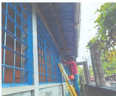
FOTOGRAFIA 3. SUMINISTRO Y REPARACION DE BALCONES, CAMBIO DE PARTES DE PERFILES DAÑADOS, LIJADO, CEPILLADO Y APLICACIÓN DE PINTURA ANTICORROSIVA
