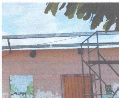
FOTOGRAFIA 7. SUMINISTRO Y SUSTITUCION DE ESTRUCTURA DE SOPORTE DE MADERA POR METAL GALVANIZADO
