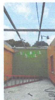
FOTOGRAFIA 6. SUMINISTRO Y SUSTITUCION DE CUBIERTA DE LAMINA ACANALADA POR LAMINA TROQUELADA CALIBRE 26 ALUZINC
