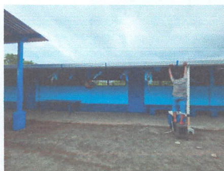
FOTOGRAFIA 4. SUMINISTRO Y SUSTITUCION DE CANAL PLUVIAL DE METAL TIPO AMERICANO
