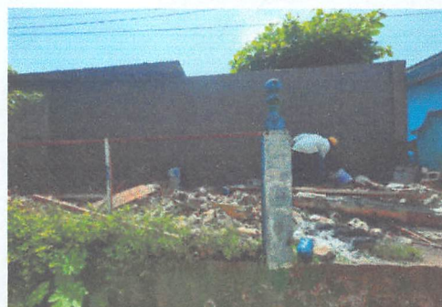
FOTOGRAFIA 2. SUMINISTRO Y SUSTITUCIÓN DE MURO PERIMETRAL EXISTENTE DE BLOCK Y COLUMNAS 20X15CM SEPARADAS A CADA 2.40M CON CIMENTO DE 50X20CM
