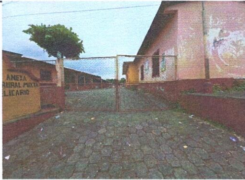
SUMINISTRO Y SUSTITUCION DE PORTON METALICO 4.26X 2.50 METROS, PUERTA CENTRAL, CON CHAPA YALE, PINTURA ANTICORROSIVA COLOR AZUL
