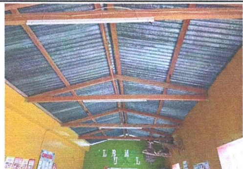
SUMINISTRO Y SUSTITUCION DE CUBIERTA DE LAMINA ACANALADA POR LAMINA TROQUELADA CALIBRE 26 ALUZINC
