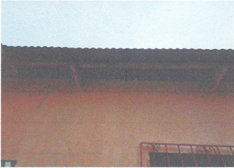
FOTOGRAFIA 7. SUMINISTRO Y SUSTITUCION DE ESTRUCTURA DE SOPORTE DE MADERA POR METAL GALVANIZADO
