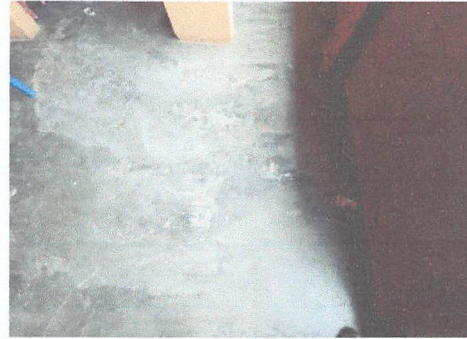
FOTOGRAFIA 8. SUMINISTRO Y SUSTITUCION DE PISO CERAMICO
