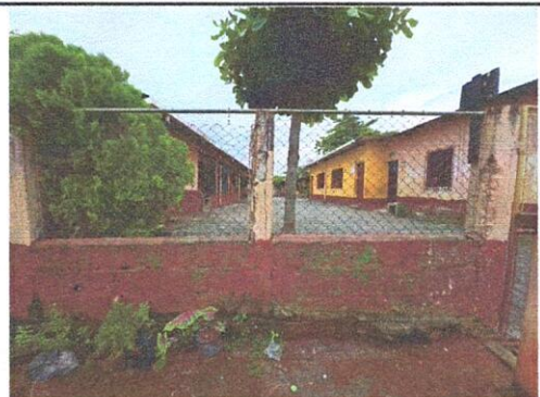
SUMINISTRO Y SUSTITUCIÓN DE MURO PERIMETRAL EXISTENTE DE BLOCK Y COLUMNAS 20X15CM SEPARADAS A CADA 2.40M CON CIMENTO DE 50X20CM
