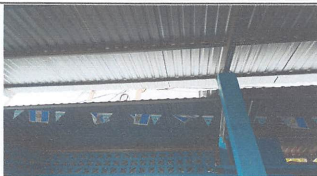
Foto 2: Mantenimiento correctivo de 57 mts lineales de lámina troquelada
