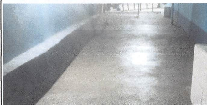
Foto 9: Sustitución de 36.5 mts 2 entortado
