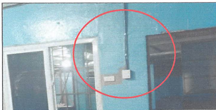
Foto 5: Sustitución de 285 mts lineales del sistema electrico
