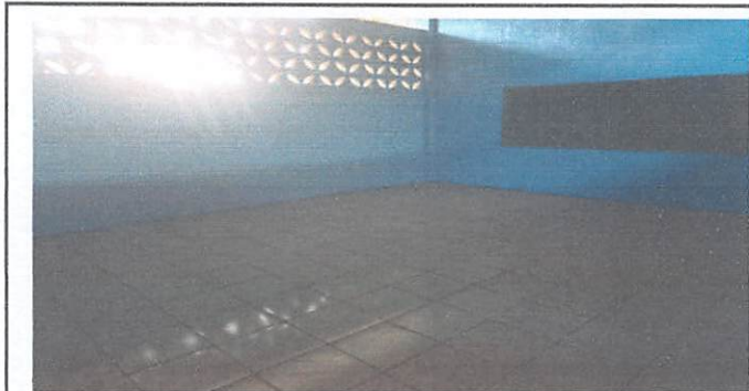
Foto 1: Sustitución de 160 mts2 de torta de cemento por piso cerámico.
