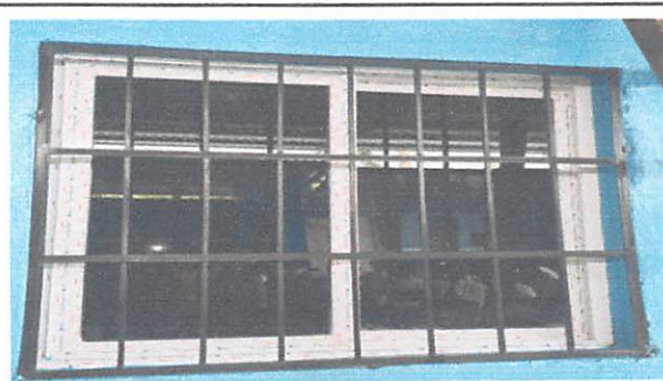
Foto 4: Fabricación y sustitución de 2.64 mts lineales de balcon
