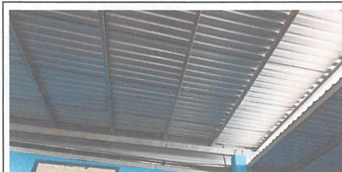
Foto 3: Sustitución de 57 mts lineales de estructura metalica
