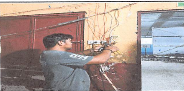
Foto 5: Sustitución de 285 mts lineales sistema electrico
