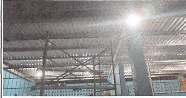
Foto 2: Mantenimiento de 57 mts lineales correctivo a lámina troquelada
