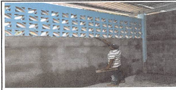
Foto 6: Reparación de 126.75 mts2 de repello y cernido de pared
