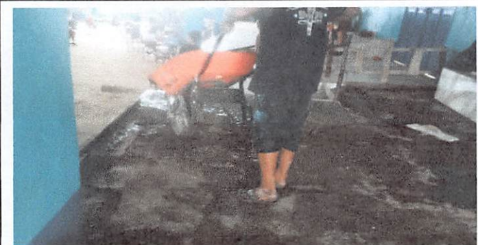
Foto 9: Sustitución de 36.5 mts 2 de entortado
