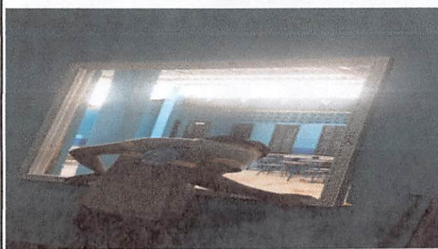
Foto 8: Sustitución de dos, ventanas de madera y metal por PVC
