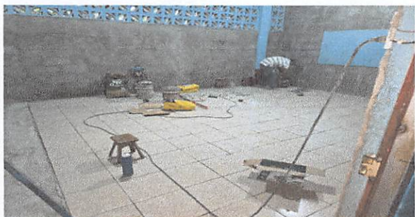
Foto 1: Sustitución de torta de 160 mts 2 de cemento por piso cerámico.
