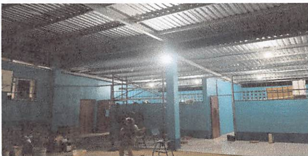
Foto 3: Sustitución de 57 mts lineales estructura metalica
