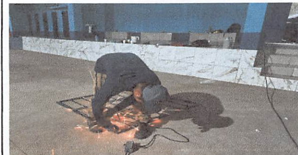
Foto 4: Fabricación y sustitución de 2.64 mts 2 de balcon
