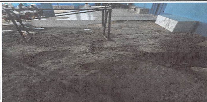
Foto 9: Sustitución de 36.50 mts2 de entortado
