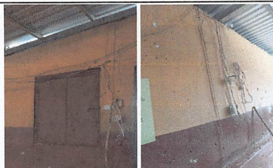
Foto 5: Sustitución de 285 mts lineales de sistema electrico
