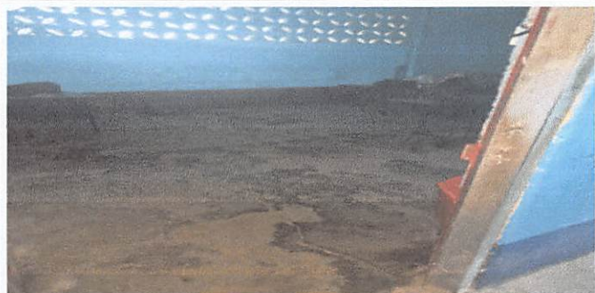
Foto 1: Sustitución de 120mts 2 de torta de cemento por piso cerámico.
