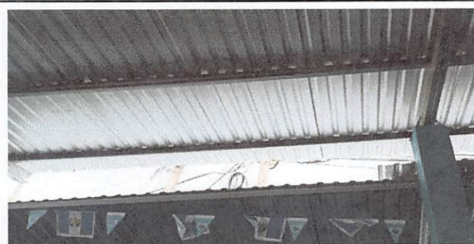
Foto 3: Sustitución de 57mts 2 de estructura metálica
