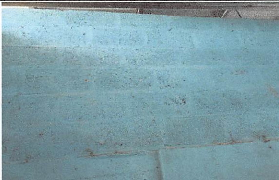
Foto 7: Suministro y aplicación de 126.75 mts 2 de pintura en muros
