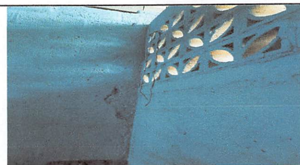
Foto 6: Reparación de 126.75 mts2 de repello y cernido de pared
