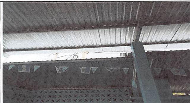
Foto 2: Mantenimiento correctivo de 57mts 2 de lámina troquelada
