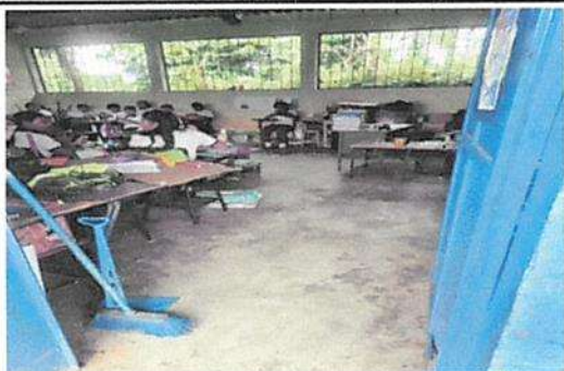
Foto 1: REPARACIÓN Y SUSTITUCIÓN DE PISO CERÁMICO
