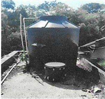
Foto 7: REPARACIÓN Y MANTENIMIENTO DE DEPÓSITO DE AGUA
