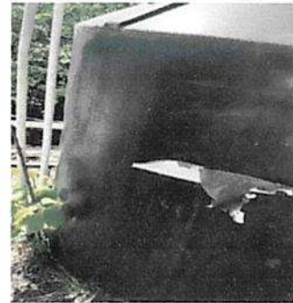
Foto 8: REPARACIÓN Y MANTENIMIENTO DE DEPÓSITO DE AGUA
