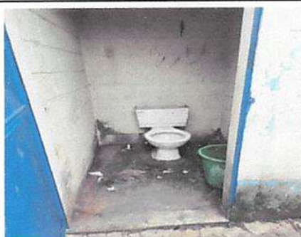
Foto 5: SUSTITUCIÓN Y MANTENIMIENTO DE SANITARIOS
