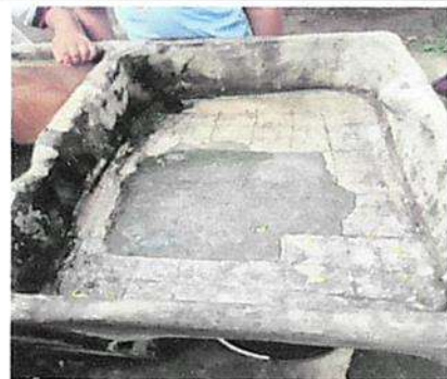
Foto 10: SUSTITUCION E INSTALACIÓN DE PILA DE CEMENTO
