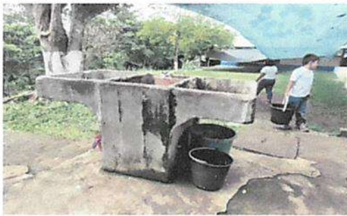
Foto 9: SUSTITUCION E INSTALACIÓN DE PILA DE CEMENTO
