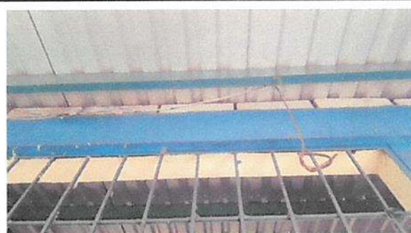
Foto 4: SUSTITUCIÓN DEL SISTEMA ELÉCTRICO
