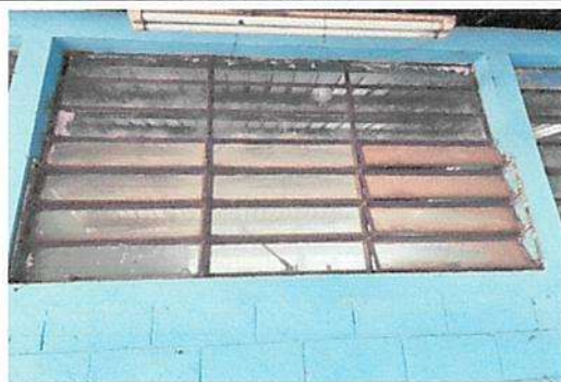
REPARACION DE BALCONES, CAMBIO DE PARTES DE PERFILES DAÑADOS, LIJADO, CEPILLADO Y APLICACIÓN DE PINTURA ANTICORROSIVA
