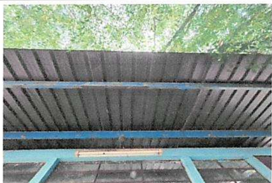
SUMINISTRO E INSTALACION DE CUBIERTA DE LAMINA POR LAMINA TROQUELADA CALIBRE 26 ALUZINC
