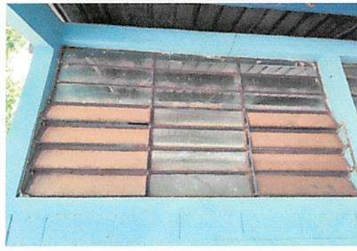
REPARACION DE BALCONES, CAMBIO DE PARTES DE PERFILES DAÑADOS, LIJADO, CEPILLADO Y APLICACIÓN DE PINTURA ANTICORROSIVA
