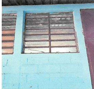
REPARACION DE BALCONES, CAMBIO DE PARTES DE PERFILES DAÑADOS, LIJADO, CEPILLADO Y APLICACIÓN DE PINTURA ANTICORROSIVA
