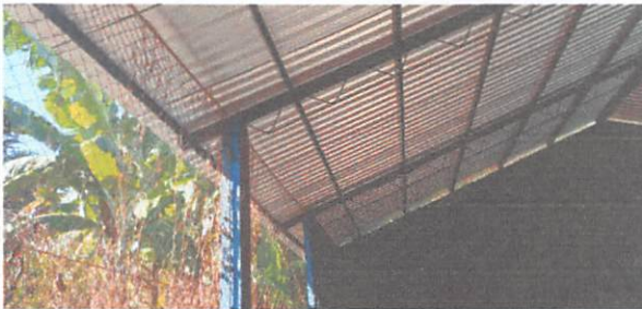
FOTO No.4 Mantenimiento a estructura de soporte de metal con anticorrosivo
