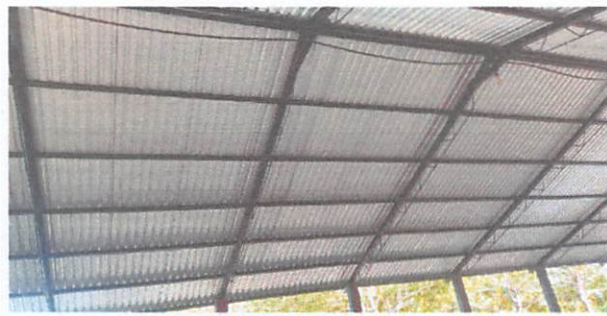
FOTO No.3 Mantenimiento a estructura de soporte de metal con anticorrosivo
