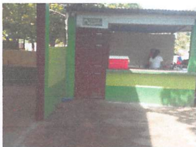
Foto No. 5 Suministro y aplicación Pintura exterior e interior en paredes
