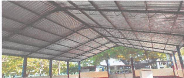
FOTO No.1: Sustrución de lámina, por lámina troquelada calibre 26
