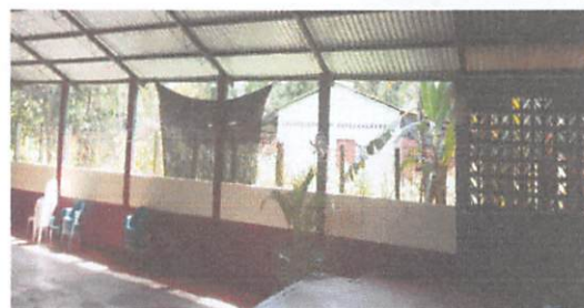
FOTO No.6 Suministro y aplicación Pintura exterior e interior en paredes
