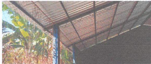
FOTO No.2 Sustrución de lámina, por lámina troquelada calibre 26
