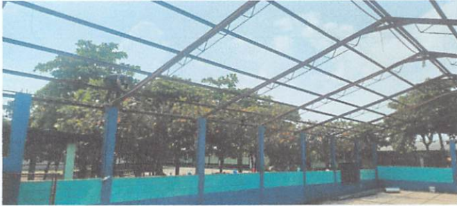
FOTO No.1: Sustrucción de lámina, por lámina troquelada calibre 26
