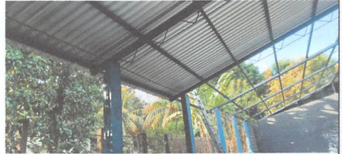
FOTO No.2 Sustrucción de lámina, por lámina troquelada calibre 26
