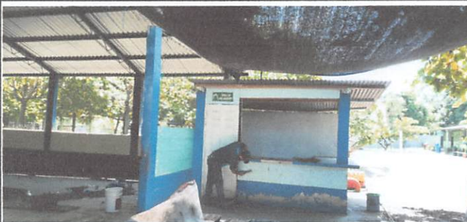
Foto No. 5 Suministro y aplicación Pintura exterior e interior en paredes
