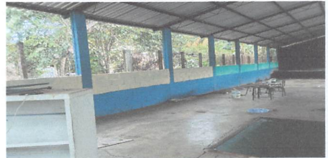
FOTO No.6 Suministro y aplicación Pintura exterior e interior en paredes
