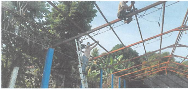
FOTO No.3 Mantenimiento a estructura de soporte de metal con anticorrosivo
