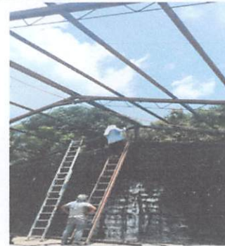
FOTO No.4 Mantenimiento a estructura de soporte de metal con anticorrosivo
