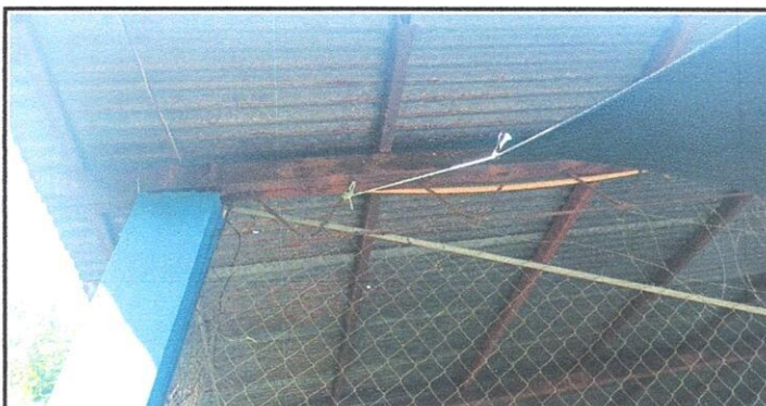
Mantenimiento a estructura de soporte de metal con anticorrosivo
