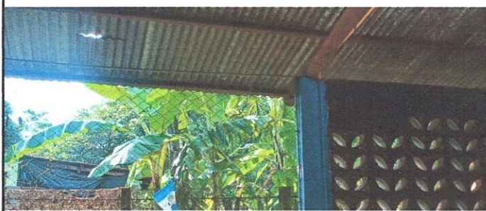
Sustitución de lámina, por lámina troquelada calibre 26
