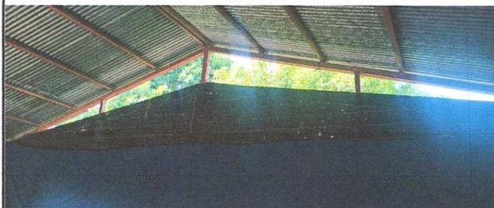
Sustitución de lámina, por lámina troquelada calibre 26
