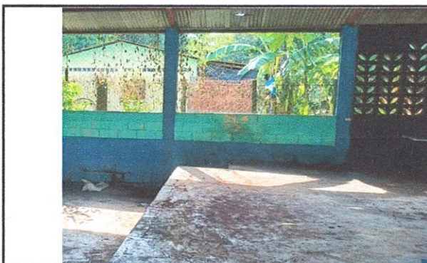
Suministro y aplicación Pintura exterior e interior en paredes
