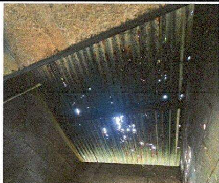
SUMINISTRO E INSTALACION DE CUBIERTA DE LAMINA POR LAMINA TROQUELADA CALIBRE 26 ALUZINC
