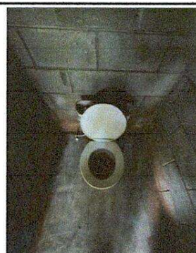
SUSTITUCIÓN INODORO ELONGADO
