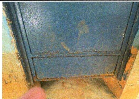
REPARACION DE PUERTAS DE METAL
