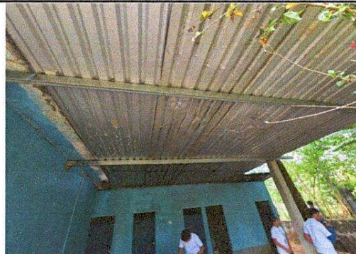
SUMINISTRO E INSTALACION DE ESTRUCTURA PORTANTE DE METAL GALVANIZADO
