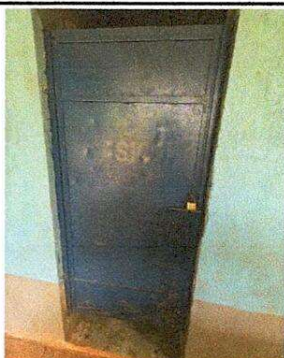
SUSTITUCION DE PUERTAS DE METAL SIN CHAPA
