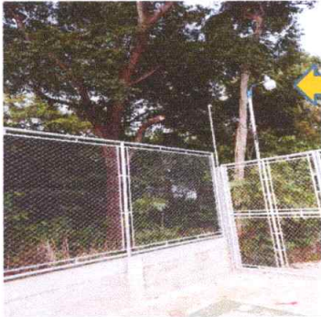
Foto 9 Sustrucción de lamparas para patio Modulo 1 y 2.
