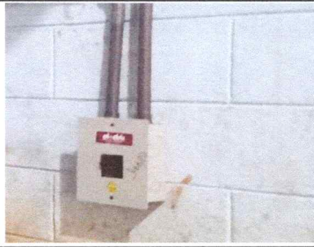
Foto 8 Sustrucción de flipones modulo 1 y 2
