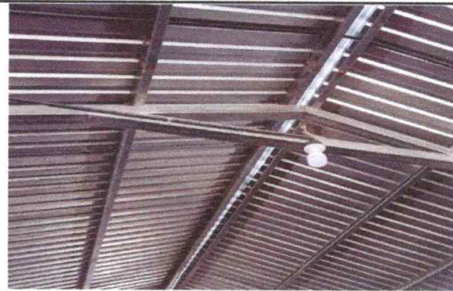
Foto 4: Reparación de cableado eléctrico CALIBRE 10 AWG, Modulo 1 y 2
