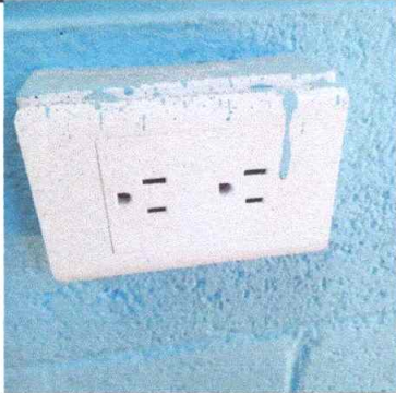
Foto 7 Sustrucción de tomacorrientes dobles Modulo 1 y 2
