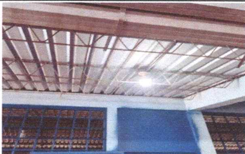
Foto 5: Sustitución de Bombillo LED GLOBO 30W 2400 Lúmenes. Modulo 1 y 2
