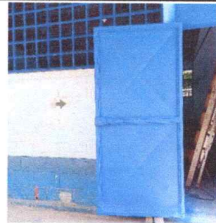
Foto 2: Mantenimiento a estructura de puertas (lijado, cambio de tubo, cepillado, sujeciones, aplicación de pintura e incluye chapa. Modulo 1 y 2
