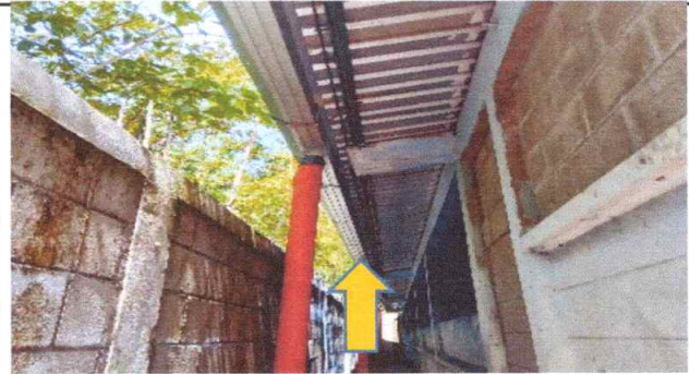
foto 10. Sustrucción de canales de metal Modulo 1 y 2
