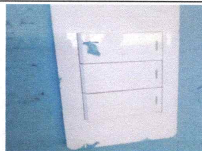
Foto 6: Sustitución interruptores dobles. Modulo 1 y 2
