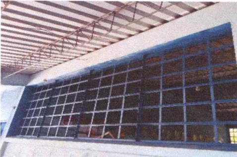
Foto 1: Mantenimiento a estructura de metal de ventana. Modulo 1 y 2
