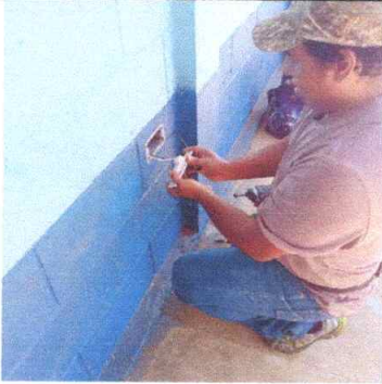
Foto7: Sustitucion de tomacorrientes dobles modulo 1 y 2
