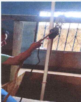
Foto 3: SUSTITUCION DE AGUA POTABLE CON BOMBA SUMERGIBLE MODULO 1
