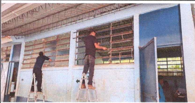
Foto1: MANTENIMIENTO A ESTRUCTURA DE METAL DE VENTANAS MODULO 1 Y 2
