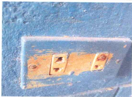
No. 7 Sustitución de tomacorrientes dobles
