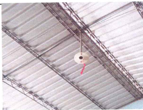
No. 5 Sustitución de bombillo Led
