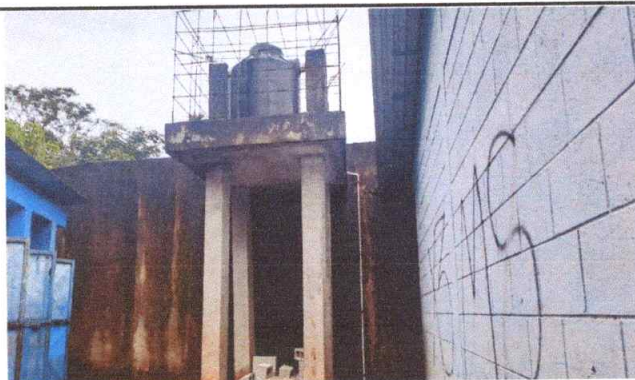
No.3 Sustitución de agua potable con bomba sumergible
