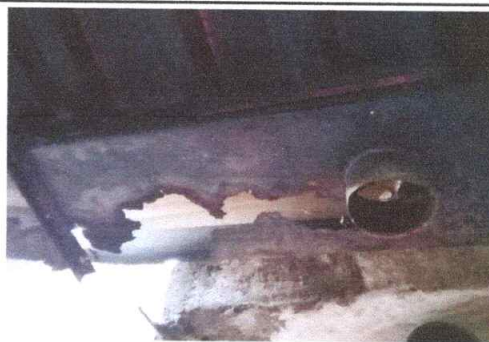
No. 10 Sustitución de canales de metal
