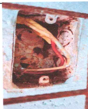
No. 6 Sustitucion de Interruptores dobles
