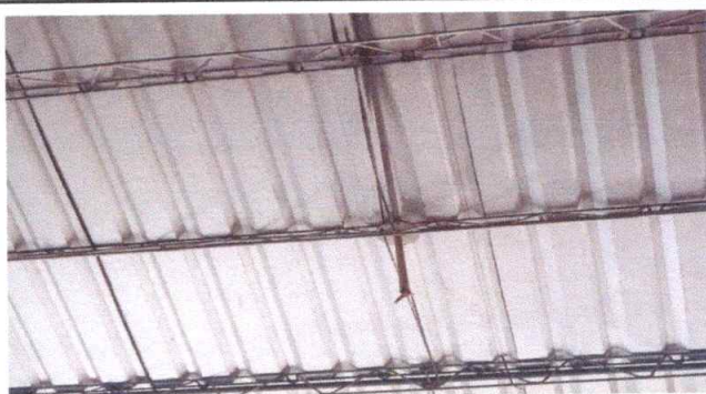
No. 4 Reparación de cableado eléctrico
