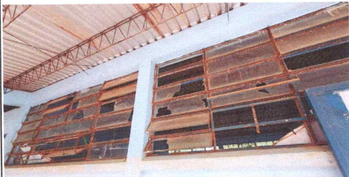
No. 1 Mantenimiento a Estructura de Metal de Ventana
