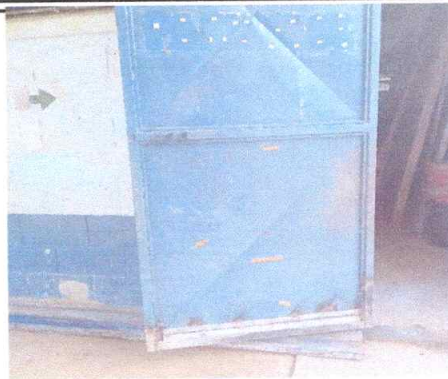
No. 2 Mantenimiento a estructura (lijado, cambio de tubo, cepillado, sujeciones, aplicado de pintura e incluye chapa)
