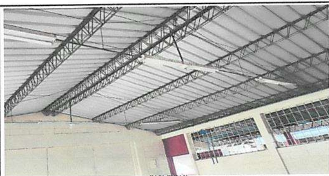
SUMINISTRO E INSTALACION DE CABLEADO ELECTRICO CALIBRE 12 AWG CONDUMEX
