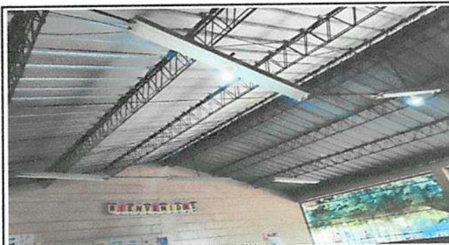
SUSTITUCIÓN DE LÁMPARAS CON LAMPARA CONTRA HUMEDAD Y POLVO CON DIFUSOR PARA 2 TUBOS LED 18 W X 48"
