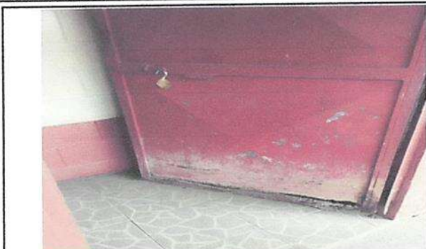
SUSTITUCION DE PUERTA METALICA CON CHAPA YALE
