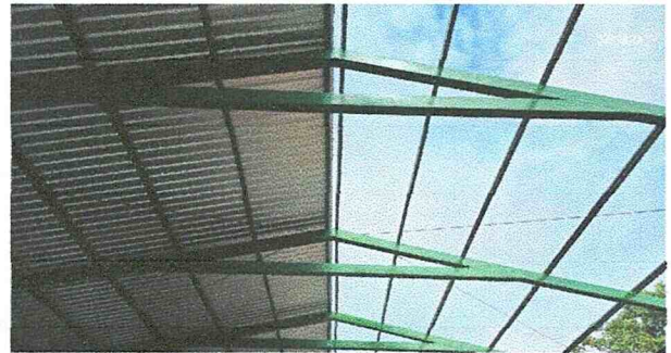
Foto 2: Mantenimiento a estructura de soporte de metal con anticorrosivo
