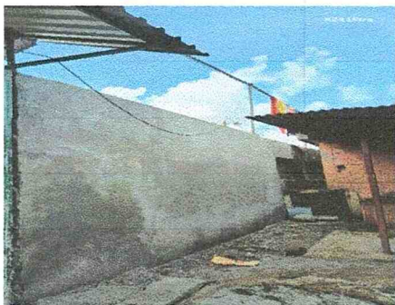
Foto 5: Repello en muro
