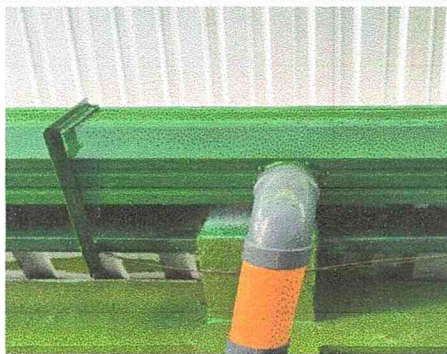
Foto 3: Sustitución de bajada de agua pluvial de metal por tubo PVC 3"
