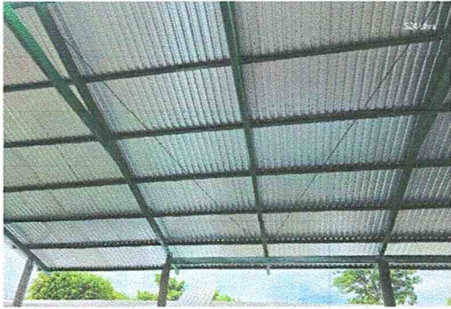
Foto 1: Sustitución de lámina, por lámina troquelada calibre 26
