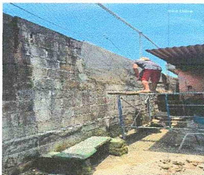
Foto 5: Repello en muro
