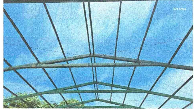
Foto 2: Mantenimiento a estructura de soporte de metal con anticorrosivo
