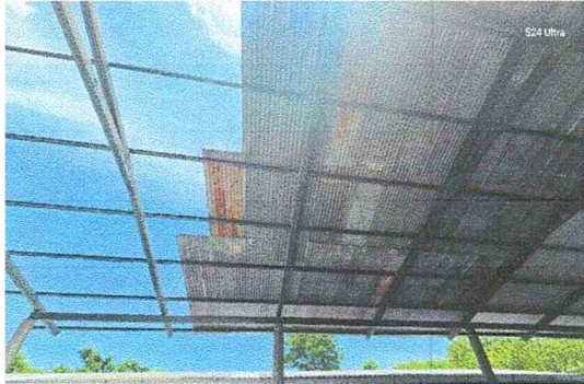
Foto 1: Sustitución de lámina, por lámina troquelada calibre 26
