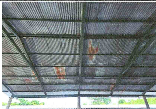
Foto 1: Sustitución de lámina, por lámina troquelada calibre 26
