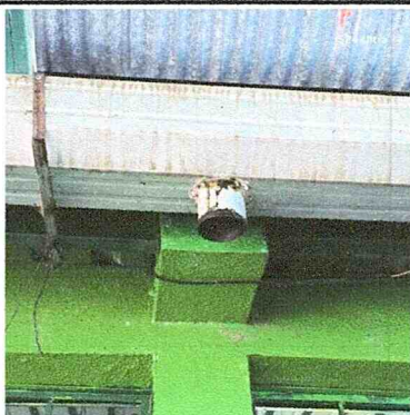
Foto 3: Sustitución de bajada de agua pluvial de metal por tubo PVC 3"
