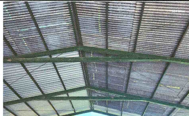
Foto 2: Mantenimiento a estructura de soporte de metal con anticorrosivo
