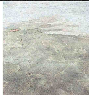
Foto 4: Sustitución de piso de torta de concreto
