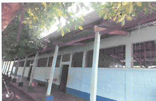
Sustitución de estructura de soporte (madera, metal) por metal
