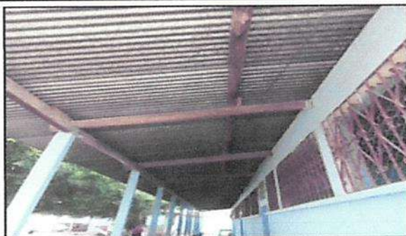
Sustitución de lámina por lámina troquelada calibre 26
