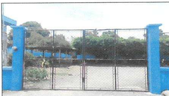
Sustitución a porton de metal (lijado, pintado, y cambio de partes de perfiles dañados).
