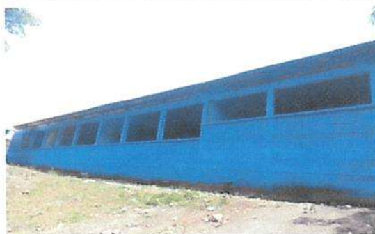
Sustitución de maya a balcones
