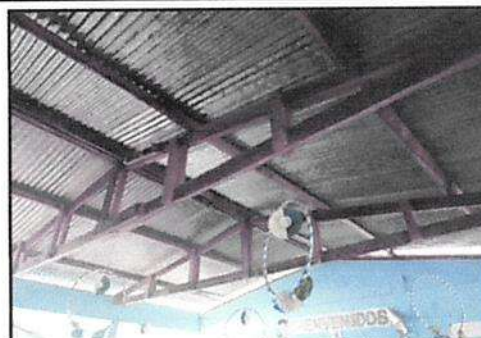
Sustitución de capote de lámina para lámina troquelada.
