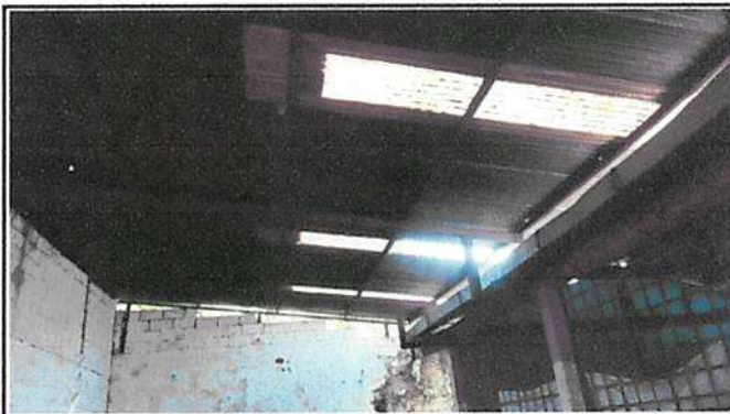
SUSTITUCIÓN DE ESTRUCTURA METALICA Y LAMINA
