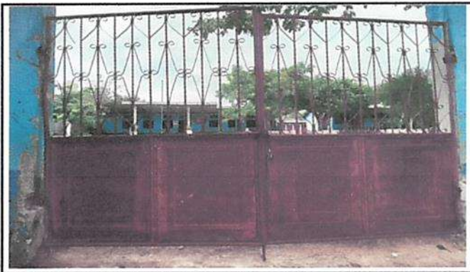
REPARACIÓN DE PORTON PRINCIPAL
