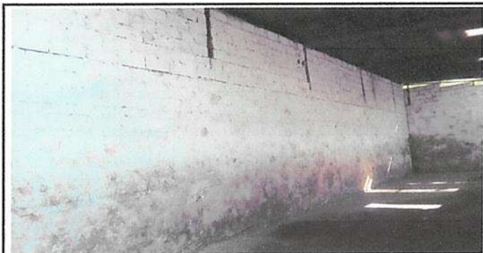
MEJORAMIENTO DE PARED CON REPELLO
