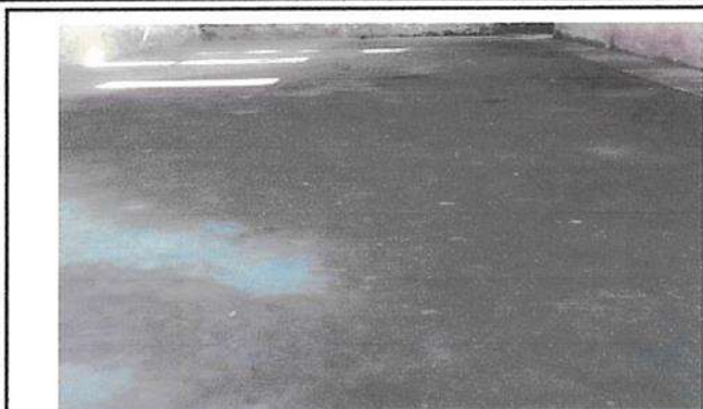
SUSTITUCION DE PISO CONCRETO A PISO CERAMICO
