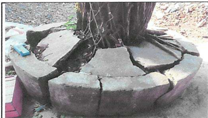
REPARACIÓN DE BORDILLO DE JARDINERA
