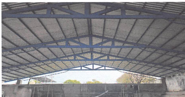
FOTO 1: MANTENIMIENTO CORRECTIVO CON SUMINISTRO DE MATERIALES PARA SUSTITUCION DE ESTRUCTURA MADERA Y LÁMINA, POR ESTRUCTURA DE METAL Y LÁMINA TROQUELADA C 26 EN ESCENARIO
