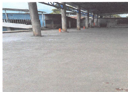
FOTO 4: MANTENIMIENTO CORRECTIVO CON SUMINISTRO DE MATERIALES PARA SUSTITUCION DE PISO AGRIETADO POR PAVIMENTO DE CONCRETO HIDRAULICO EN CANCHA
