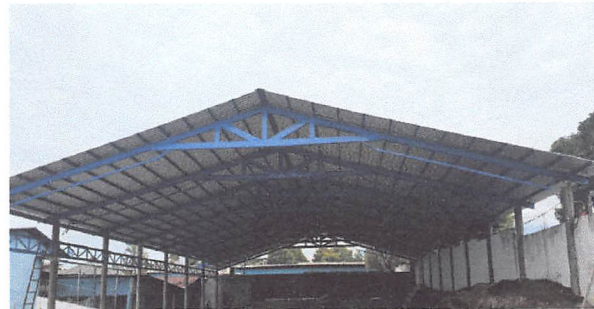
FOTO 2: MANTENIMIENTO CORRECTIVO CON SUMINISTRO DE MATERIALES PARA SUSTITUCION DE ESTRUCTURA MADERA Y LÁMINA, POR ESTRUCTURA DE METAL Y LÁMINA TROQUELADA C 26 EN PARTE FRONTAL DE TECHO DE CANCHA
