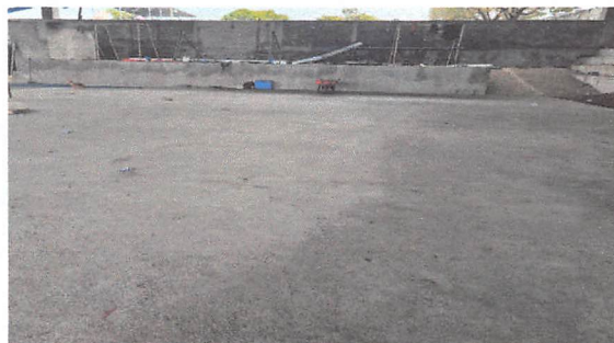
FOTO 3: MANTENIMIENTO CORRECTIVO CON SUMINISTRO DE MATERIALES PARA SUSTITUCION DE PISO AGRIETADO POR PAVIMENTO DE CONCRETO HIDRAULICO EN CANCHA
