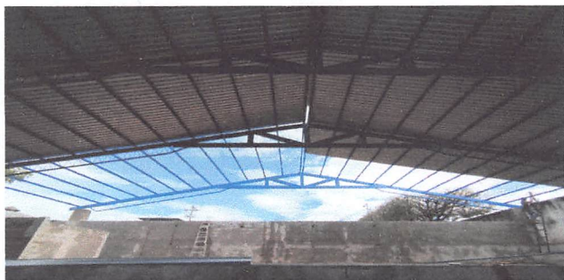
FOTO 1: MANTENIMIENTO CORRECTIVO CON SUMINISTRO DE MATERIALES PARA SUSTITUCION DE ESTRUCTURA MADERA Y LÁMINA, POR ESTRUCTURA DE METAL Y LÁMINA TROQUELADA C 26 EN ESCENARIO
