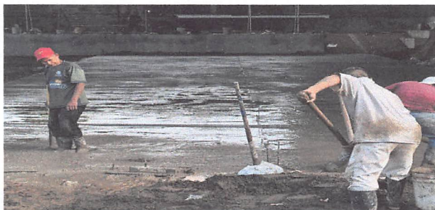
FOTO 3: MANTENIMIENTO CORRECTIVO CON SUMINISTRO DE MATERIALES PARA SUSTITUCION DE PISO AGRIETADO POR PAVIMENTO DE CONCRETO HIDRAULICO EN CANCHA
