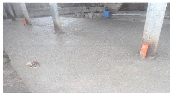
FOTO 4: MANTENIMIENTO CORRECTIVO CON SUMINISTRO DE MATERIALES PARA SUSTITUCION DE PISO AGRIETADO POR PAVIMENTO DE CONCRETO HIDRAULICO EN CANCHA
