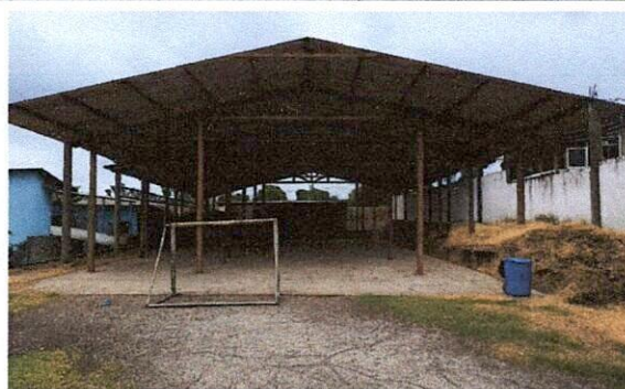
MANTENIMIENTO CORRECTIVO CON SUMINISTRO DE MATERIALES PARA SUSTITUCION DE ESTRUCTURA MADERA Y LÁMINA, POR ESTRUCTURA DE METAL Y LÁMINA TROQUELADA C 26 EN PARTE FRONTAL DE TECHO DE CANCHA
