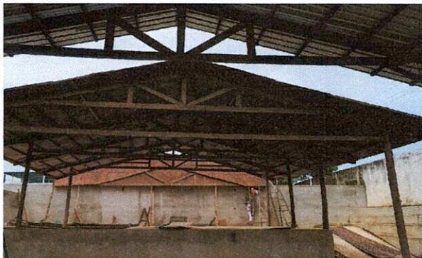
MANTENIMIENTO CORRECTIVO CON SUMINISTRO DE MATERIALES PARA SUSTITUCION DE ESTRUCTURA MADERA Y LÁMINA, POR ESTRUCTURA DE METAL Y LÁMINA TROQUELADA C 26 EN ESCENARIO
