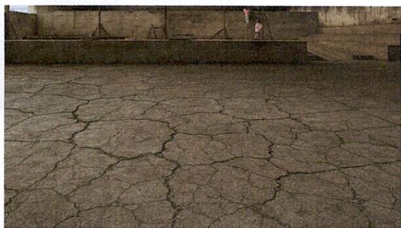
MANTENIMIENTO CORRECTIVO CON SUMINISTRO DE MATERIALES PARA SUSTITUCION DE PISO AGRIETADO POR PAVIMENTO DE CONCRETO HIDRAULICO EN CANCHA
