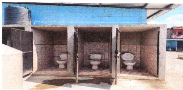
FOTO 5: Sustitución de azulejo en sanitarios
