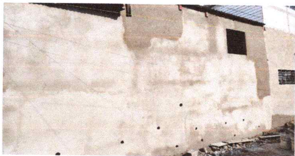
FOTO 1: Reparación de muro de block con columnas de 0.20x0.20x4.00
