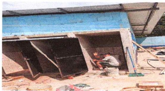
FOTO 5: Sustitución de azulejo en sanitarios
