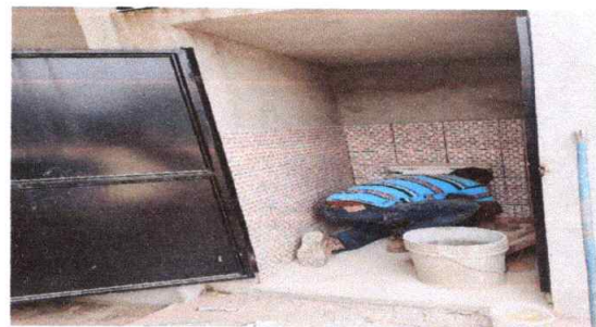
FOTO 6: Sustitución de piso de concreto por piso cerámico en sanitarios
