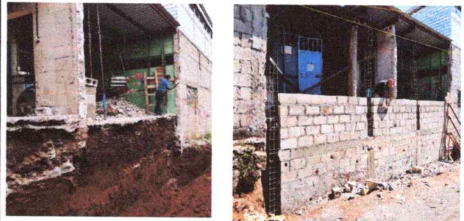
FOTO 2: Reparación de muro con block de 50Kg/cm2 14x19x39cm
