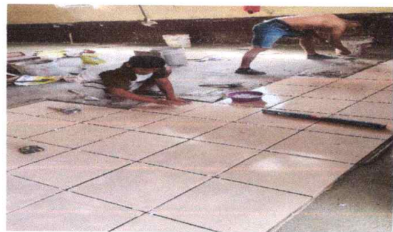
FOTO 4: Sustitución de piso de concreto por piso cerámico en aulas
