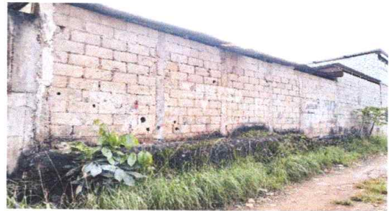
FOTO 2: Reparación de muro con block de 50Kg/cm2 14x19x39cm
