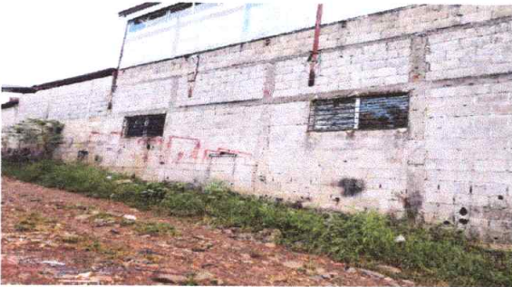
FOTO 3: Repello gris en muro
