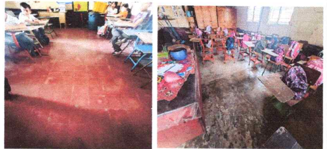
FOTO 4: Sustitución de piso de concreto por piso cerámico en aulas
