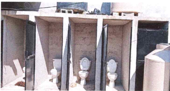
FOTO 5: Sustitución de azulejo en sanitarios
