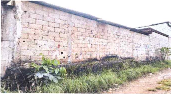
FOTO 1: Reparación de muro de block con columnas de 0.20x0.20x4.00
