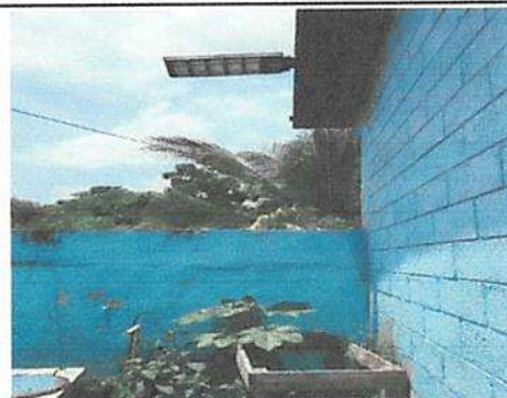
Foto 4: SUSTITUCIÓN E INSTALACIÓN DE LAMPARAS SOLARES
