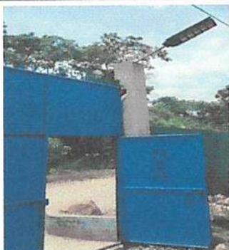
Foto 3: SUSTITUCIÓN E INSTALACIÓN DE LAMPARAS SOLARES
