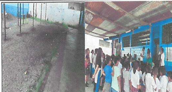
Reparación , sustitución de soporte de madera por metal y Sustitución de lámina, por lámina troquelada Calibre 26.
