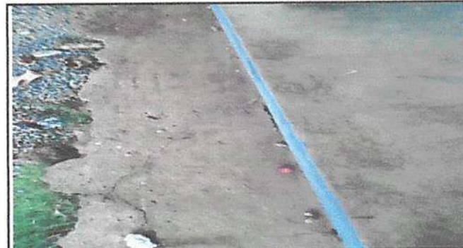
Sustitución de torta de cemento con espesor de 10 cm concreto 3000 psi.
