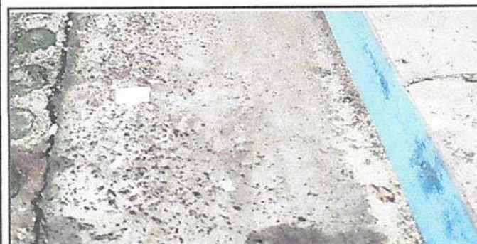
Sustitución de torta de cemento con espesor de 10 cm concreto 3000 psi.
