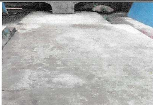
MANTENIMIENTO DE FOSA SEPTICA
