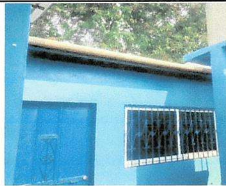
SUSTITUCIÓN DE CANAL PVC POR METAL
