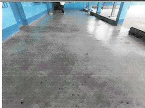
SUSTITUCIÓN DE PISO DE CEMENTO POR CERAMICO
