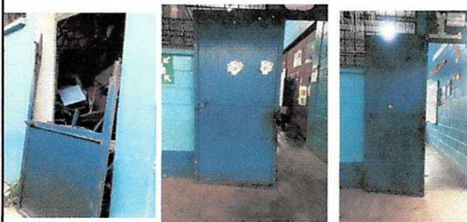
SUSTITUCIÓN DE PUERTAS DE METAL
