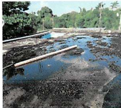
SUMINISTRO DE IMPERMEABILIZANTE PARA MANTENIMIENTO DE LOSA
