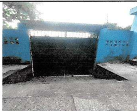
REPARACIÓN DE PORTON
