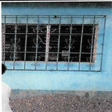
SUSTITUCION DE VENTANA POR VENTANA PVC
