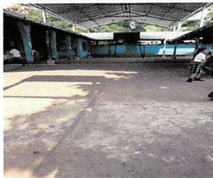
MANTENIMIENTO DE PISO CANCHA DEPORTIVA APLICACIÓN DE PINTURA
