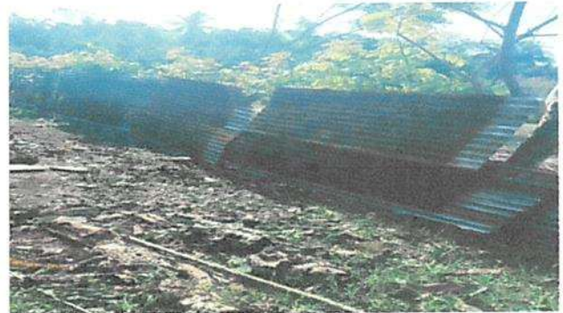
Mantenimiento correctivo con sustitucion de cerco Perimetral metalico por barda Pre-fabricada.
