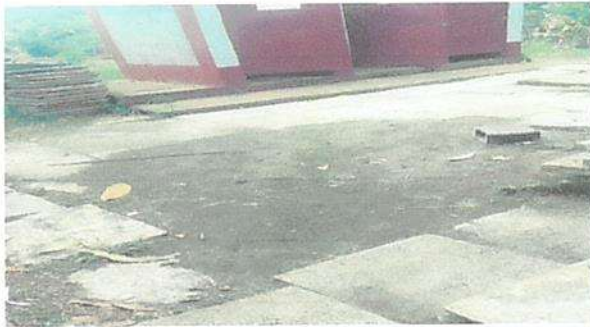
Mantenimiento correctivo con reparacion de plancha de concreto de patio.
