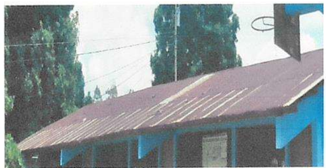
Sustitución de lámina por lámina troquelada Calibre 26
