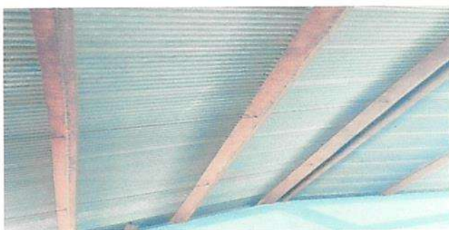
Sustitución de lámina por lámina troquelada Calibre 26
