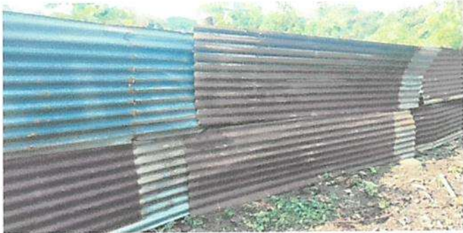
Mantenimiento correctivo con sustitucion de cerco Perimetral metalico por barda Pre-fabricada.
