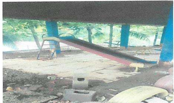
Mantenimiento correctivo con reparacion de plancha de concreto de patio.
