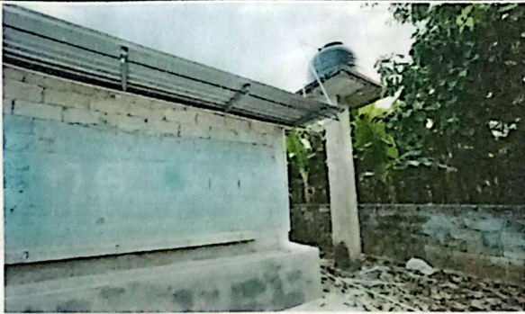
FOTOGRAFIA 9. INSTALACION DE SISTEMA DE AGUA POTABLE CON ELECTROVALVULA DE LLENADO. TOTAL 2 SISTEMAS
