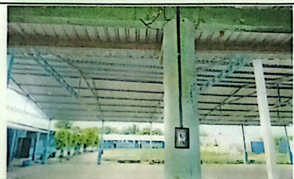
FOTOGRAFIA 4. INSTALACION DE TOMACORRIENTES DOBLES POLARIZADO 15A EAGLE, 14 AULAS Y PASILLOS, TOTAL 31 TOMACORRIENTES
