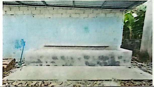
FOTOGRAFIA 10. INSTALACION DE LAVAMANOS DE CONCRETO 5 CHORROS. TOTAL 1 LAVAMANOS
