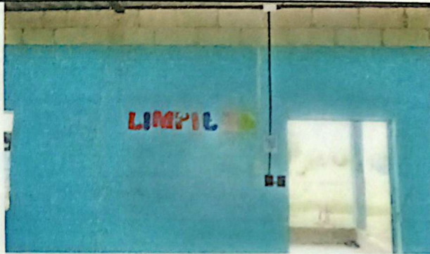
FOTOGRAFIA 3. SUSTITUCION DE INTERRUPTORES SIMPLES POLARIZADA 15A EAGLE, 14 AULAS, TOTAL 35 INTERRUPTORES
