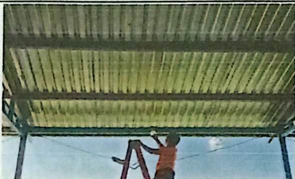
FOTOGRAFIA 1. SUSTITUCIÓN DE BOMBILLO LED GLOBO 30W 2400 LÚMENES. 14 AULAS Y CANCHA DEPORTIVA. TOTAL 75 BOMBILLOS
