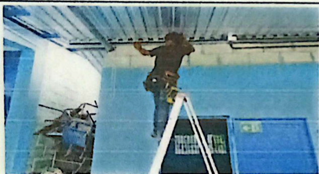
FOTOGRAFIA 5. INSTALACION DE CABLEADO ELECTRICO CALIBRE 12 AWG VIAKON, 14 AULAS, PASILLOS Y CORREDORES, TOTAL 700 METROS LINEALES
