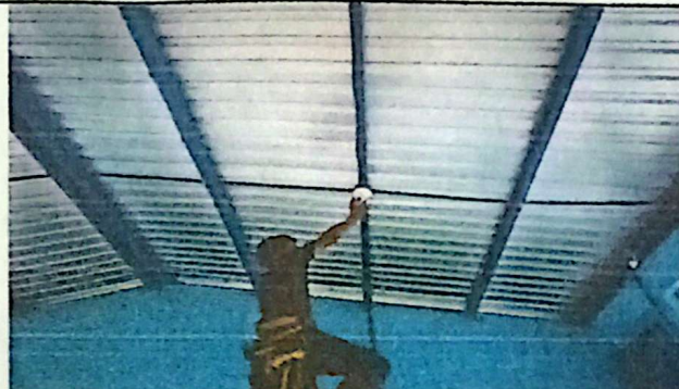
FOTOGRAFIA 2. SUSTITUCION DE PLAFONERAS, 14 AULAS, CANCHA DEPORTIVA. TOTAL 75 PLAFONERAS
