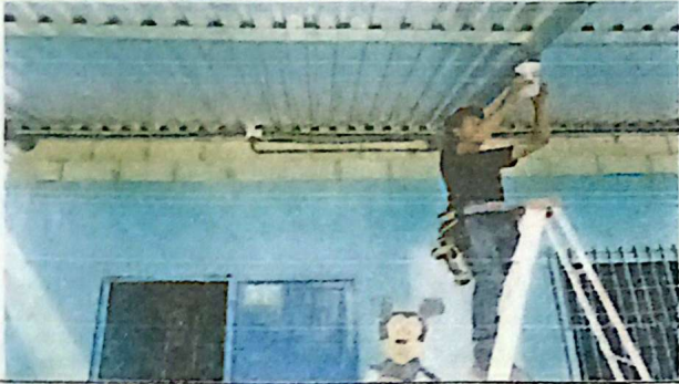
FOTOGRAFIA 7. INSTALACION DE CABLEADO ELECTRICO CALIBRE 8 AWG VIAKON, 14 AULAS, PASILLOS Y CORREDORES, TOTAL 315 METROS LINEALES
