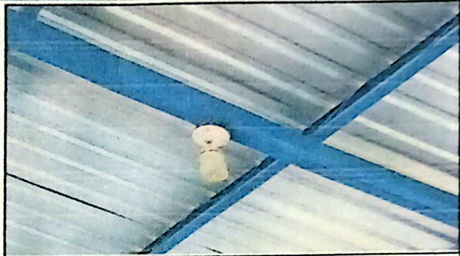
FOTOGRAFIA 2. SUSTITUCIÓN DE PLAFONERAS. 14 AULAS, CANCHA DEPORTIVA. TOTAL 75 PLAFONERAS
