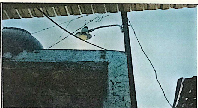
FOTOGRAFIA 11. SUSTITUCIÓN DE LÁMPARAS TIPO CANASTA PARA EXTERIOR. TOTAL 10 LÁMPARAS
