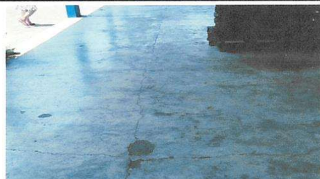
Foto 2: REPARACIÓN Y SUSTITUCIÓN DE PISO CERÁMICO
