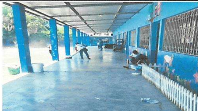
Foto 1: REPARACIÓN Y SUSTITUCIÓN DE PISO CERÁMICO
