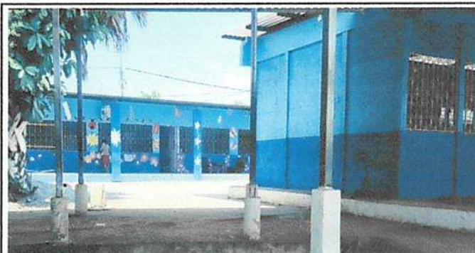
Foto 4: REPARACIÓN DE ACERA DE CONCRETO
