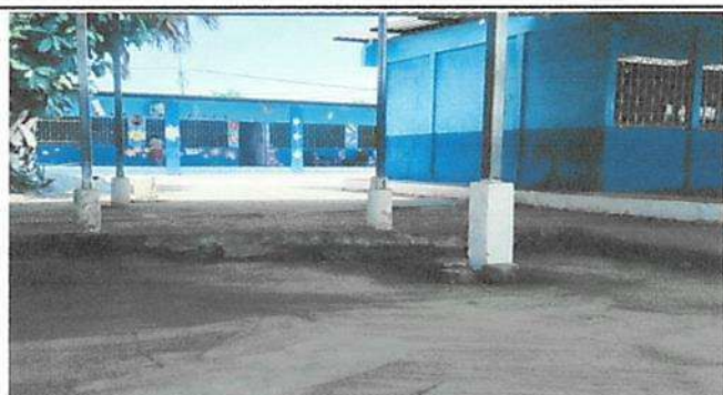
Foto 3: REPARACIÓN DE RAMPA DE CONCRETO
