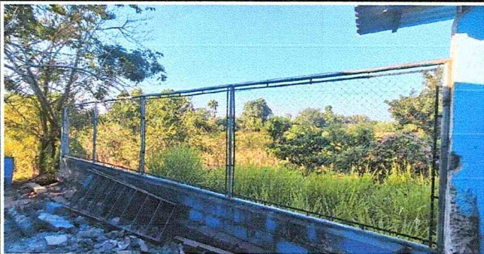
Foto #7: Sustrucción de tubo HG y malla galvanizada. 14.1 m2
