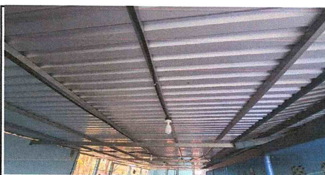
Foto #6: Reparación de sistema eléctrico. 285 ml
