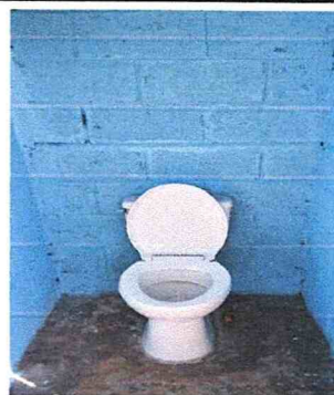
Foto #4: Sustitución de sanitarios. 4 Unidades.
