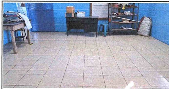
Foto #3: Sustitución de piso cerámico. 126.04 m2
