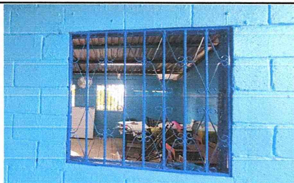
Foto #2: Reparación y sustitución de balcones. 26 m2
