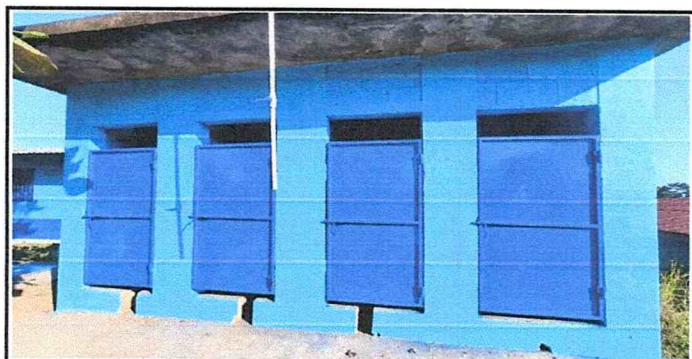
Foto #5: Sustitución de puertas de baño. 4 Unidades.
