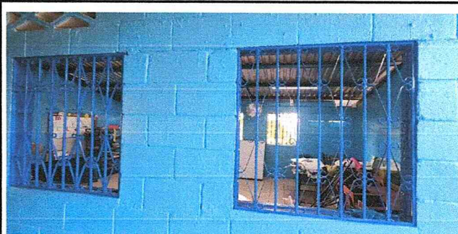
Foto #8: Pintura de muros interiores y exteriores de aula. 220 m2
