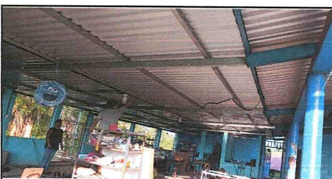
Foto #6: Reparación de sistema eléctrico. 285 ml
