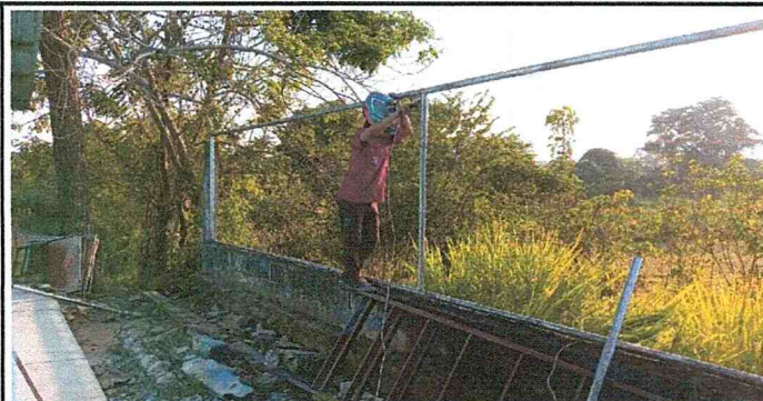
Foto #7: Sustitución de tubo HG y malla galvanizada. 14.1 m2
