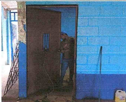
Foto #1: Mantenimiento de puertas de aulas. 4 Unidades.
