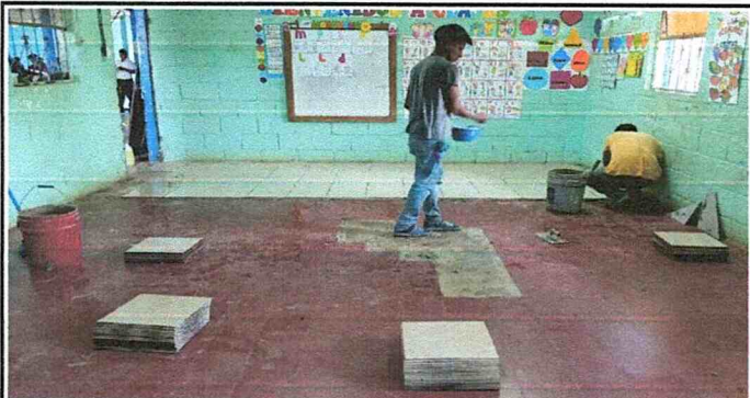
Foto #3: Sustitución de piso cerámico. 126.04 m2
