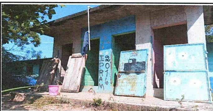
Foto #5: Sustitución de puertas de baño. 4 Unidades.
