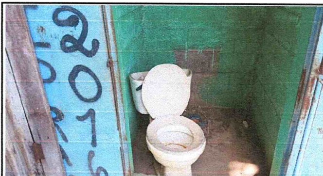
Foto #4: Sustitución de sanitarios. 4 Unidades.
