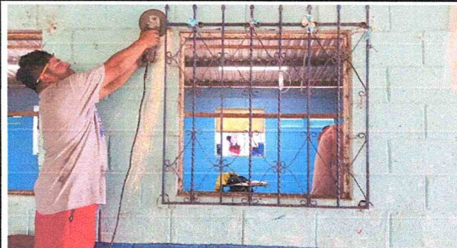
Foto #2: Reparación y sustitución de balcones. 26 m2
