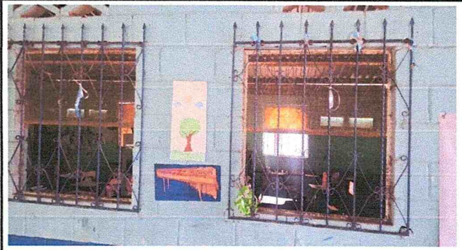
Foto #8: Pintura de muros interiores y exteriores de aula. 220 m2
