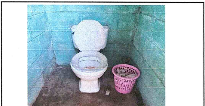
Foto #4: Sustitución de sanitarios. 4 Unidades.
