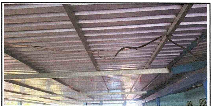
Foto #6: Reparación de sistema eléctrico. 285 ml
