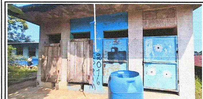
Foto #5: Sustitución de puertas de baño. 4 Unidades.
