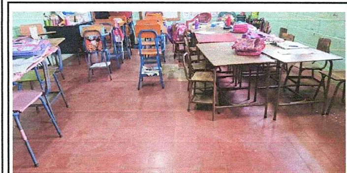
Foto #3: Sustitución de piso cerámico. 126.04 m2
