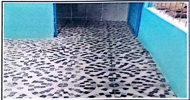
Mantenimiento y sustitución de piso de concreto cerámico y pared.
