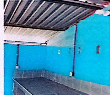
Mantenimiento correctivo con sustitución de sistema eléctrico.
