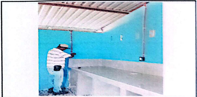
Mantenimiento correctivo con sustitución de sistema eléctrico.
