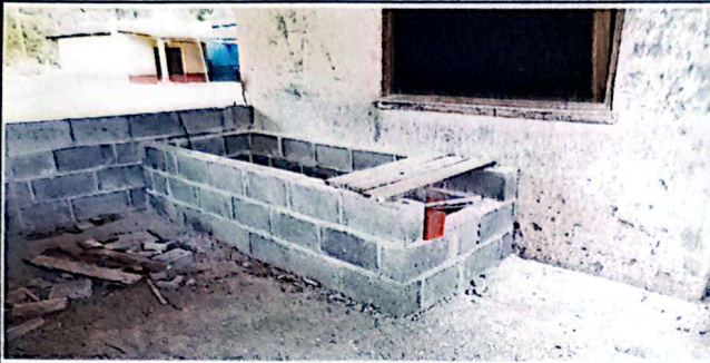
Mantenimiento correctivo con sustitución de estufa con block y azulejo.
