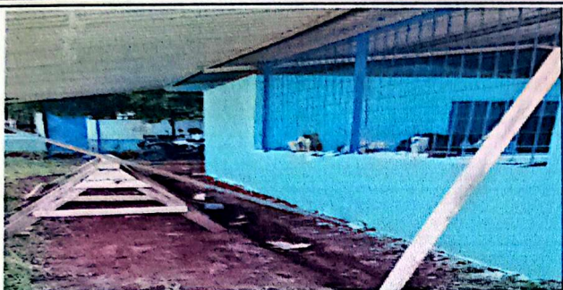
Suministro y aplicación pintura interior y exterior.
