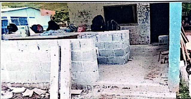
Mantenimiento correctivo con sustitución de mesas de trabajo en cocina.
