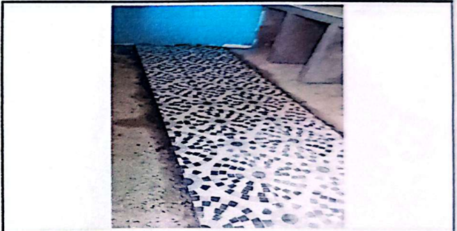
Mantenimiento y sustitución de piso de concreto cerámico y pared.
