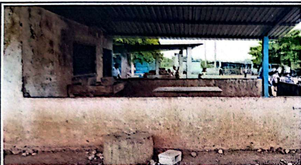
Suministro y aplicación pintura interior y exterior
