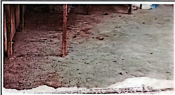
Mantenimiento y sustitución de piso de concreto cerámico y pared
