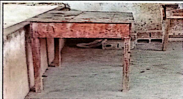
Mantenimiento correctivo con sustitución de mesas de trabajo en cocina
