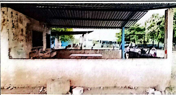
Mantenimiento correctivo con sustitución de balcones y puerta
