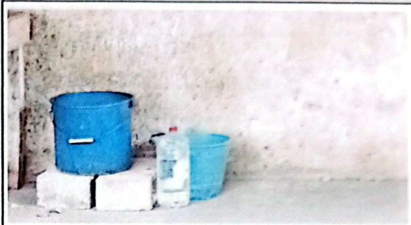
Mantenimiento correctivo con sustitución de tanque con tubería de agua potable
