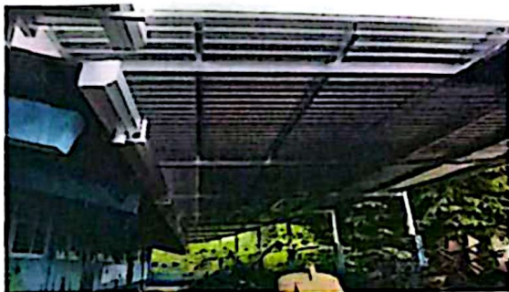
Sustitución de láminas, por lámina troquelada Calibre 26 - Total 191.00 m2
