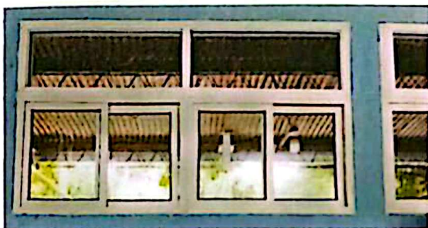
Sustitución de metal por PVC en ventanales - m2. 60.00
