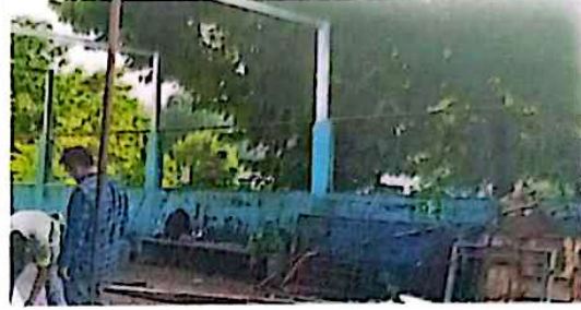
Sustitución de estructura de soporte (madera, metal) por metal - Total 191.00 m2
