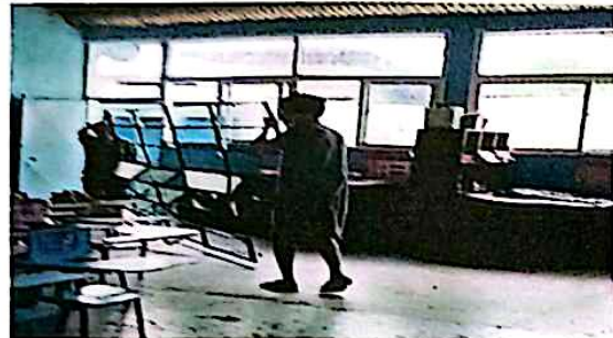
Sustitución de metal por PVC en ventanales - Total 50.00 m2
