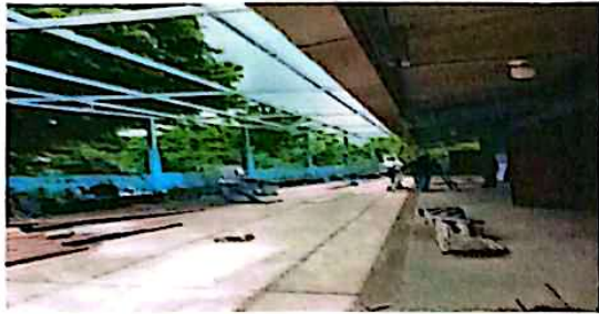
Sustitución de láminas, por lámina troquelada Calibre 26 - Total 191.00 m2
