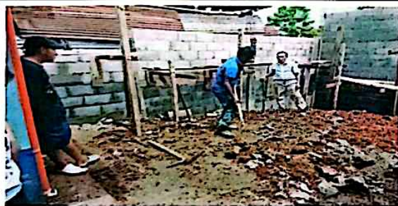
Sustitución de piso de torta de concreto - Total 34.00 m2
