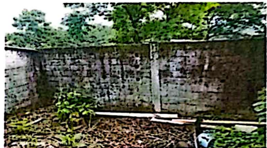
Sustitución de muro perimetral existente de block y columnas 20x15 cm separadas a cada 2.4 m con cimbrío y columnas - m2. 40.00
