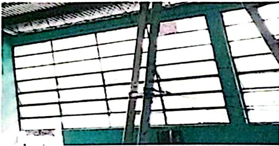
Sustitución de metal por PVC en ventanales - m2. 50.00
