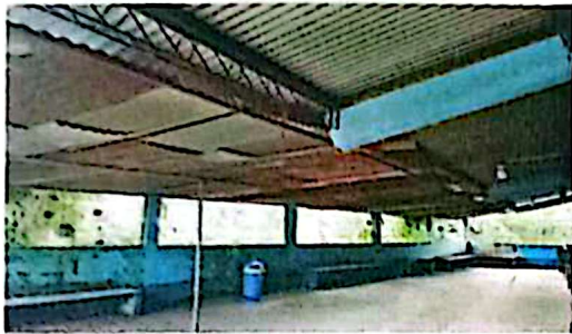
Sustitución de láminas, por lámina troquelada Calibre 26 - m2. 191.00
