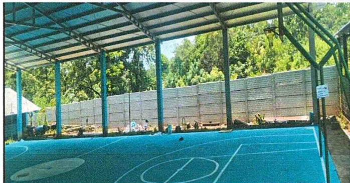
FOTO #1 Sustitución de muro perimetral con barda prefabricada de concreto h:2.50.84 metros cuadrados
