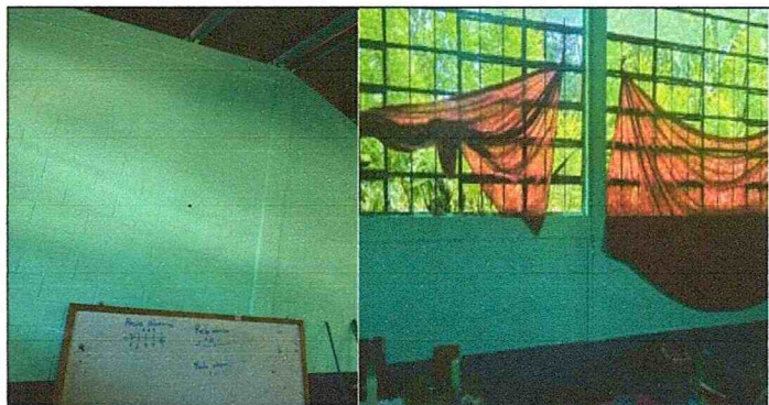
FOTO # 3.- Suministro y aplicación de pintura interior y exterior pantone 293 para muros
