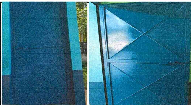
FOTO #4.- Mantenimiento de puertas (lijado, cambio de tubo, cepillado, sujeciones, aplicado de pintura)
