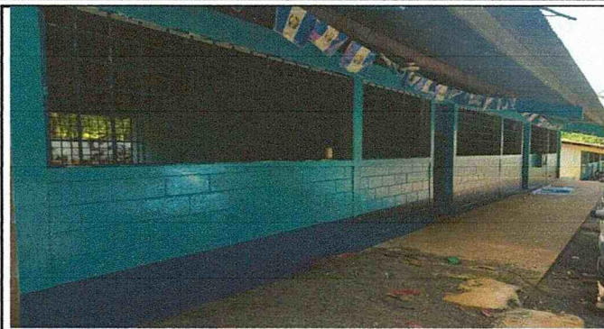
FOTO #2.- Suministro y aplicación de pintura interior y exterior pantone 293 para muros
