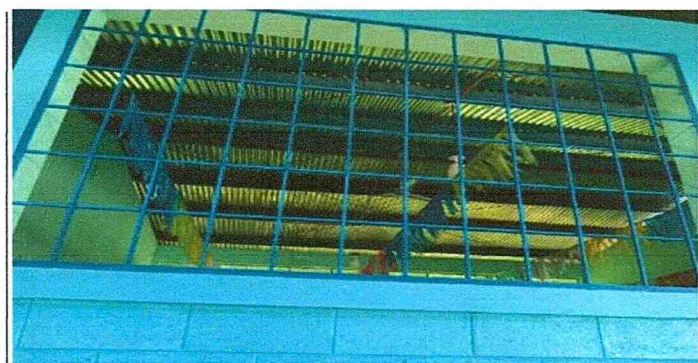
FOTO.- # 5.- Mantenimiento a balcones
