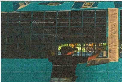
FOTO.- # 5.- Mantenimiento a balcones
