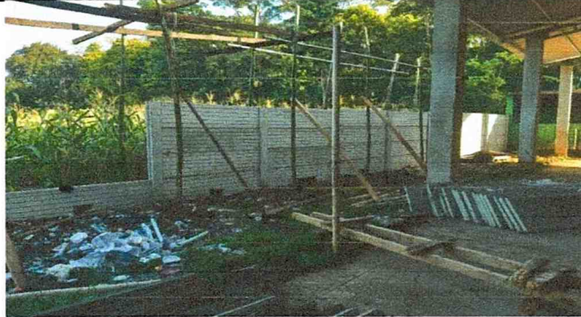
FOTO. #1 Sustrucción de muro perimetral con barda prefabricada de concreto h:2.50.84 metros cuadrados
