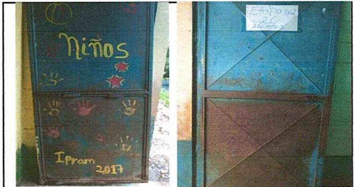
FOTO. #4.- Mantenimiento de puertas (lijado, cambio de tubo, cepillado, sujeciones, aplicado de pintura)
