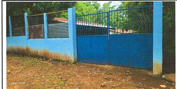
FOTO.- # 6.- Mantenimiento a portón metálico
