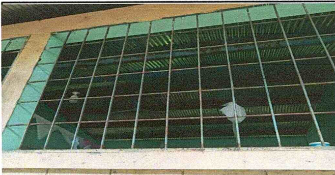
FOTO.- # 5.- Mantenimiento a balcones
