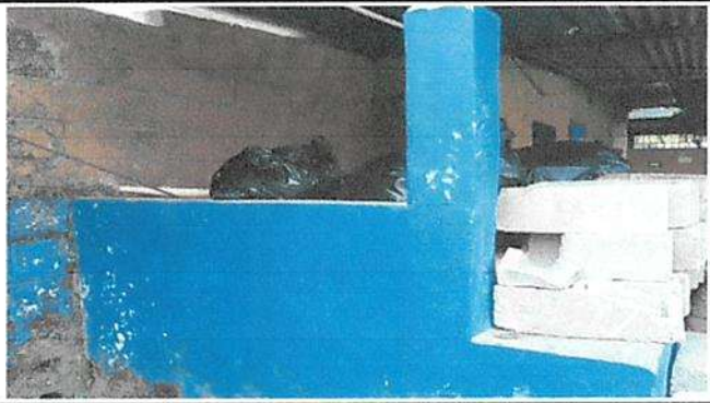
Sustitución de basurero con estructura metálica con marcos de tubo cuadrado galvanizado
