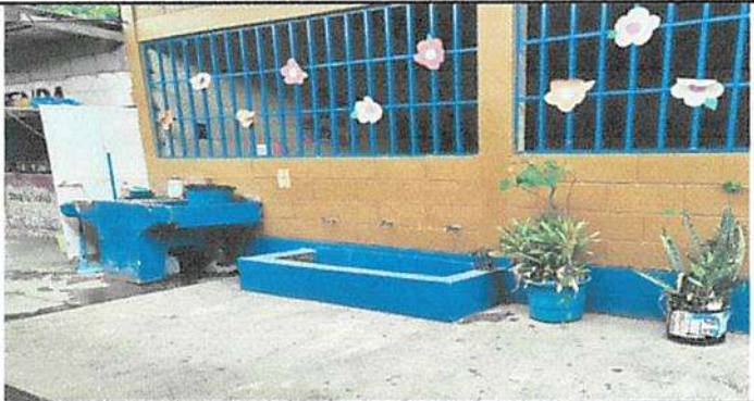
Suministro y sustitución de pila de concreto
