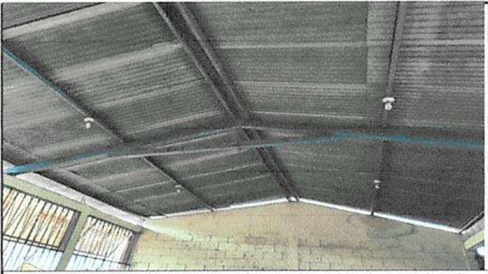
Suministro e instalación de iluminación en aulas cableado y canaleta de protección
