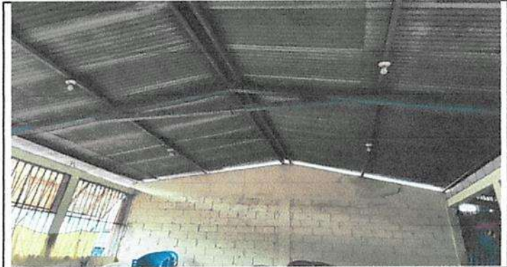
Sustitución de cubierta metálica con lamina troquelada calibre 26 de aula
