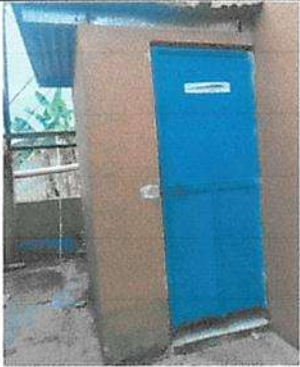
Suministro y sustitución de puerta de servicio sanitario de 1.80*0.80
